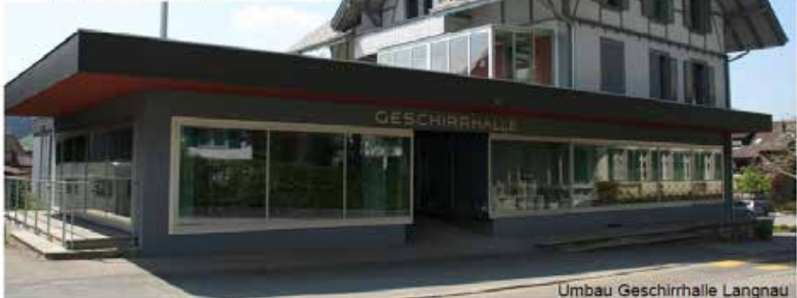
Umbau Geschirrhalle Langnau
