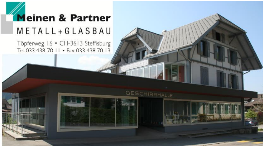
Umbau Geschirrhalle Langnau
