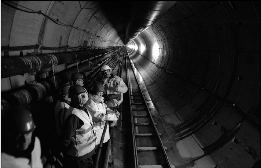
Hr. Popp und Seeclubler im Entlastungsstollen
