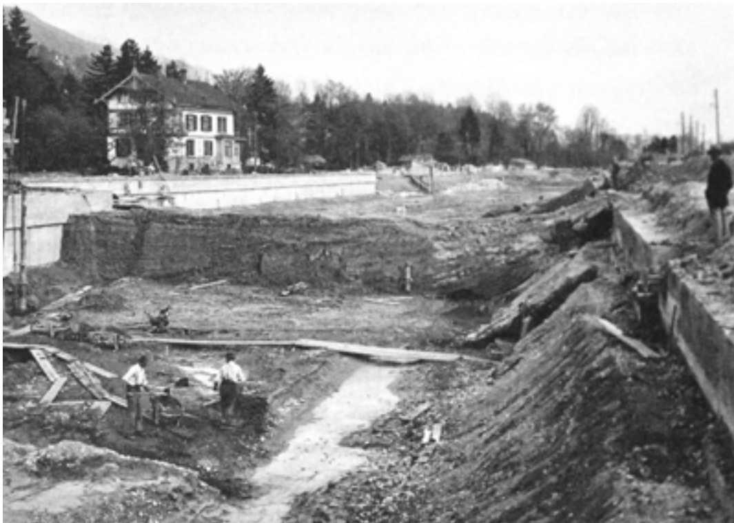
Thun, Schiffskanal, 4. Mai 1925 - Für die offizielle Eröffnung am 27. Juni 1925 wurde der Kanal geflutet, die Bauarbeiten dauerten bis Mai 1926.
