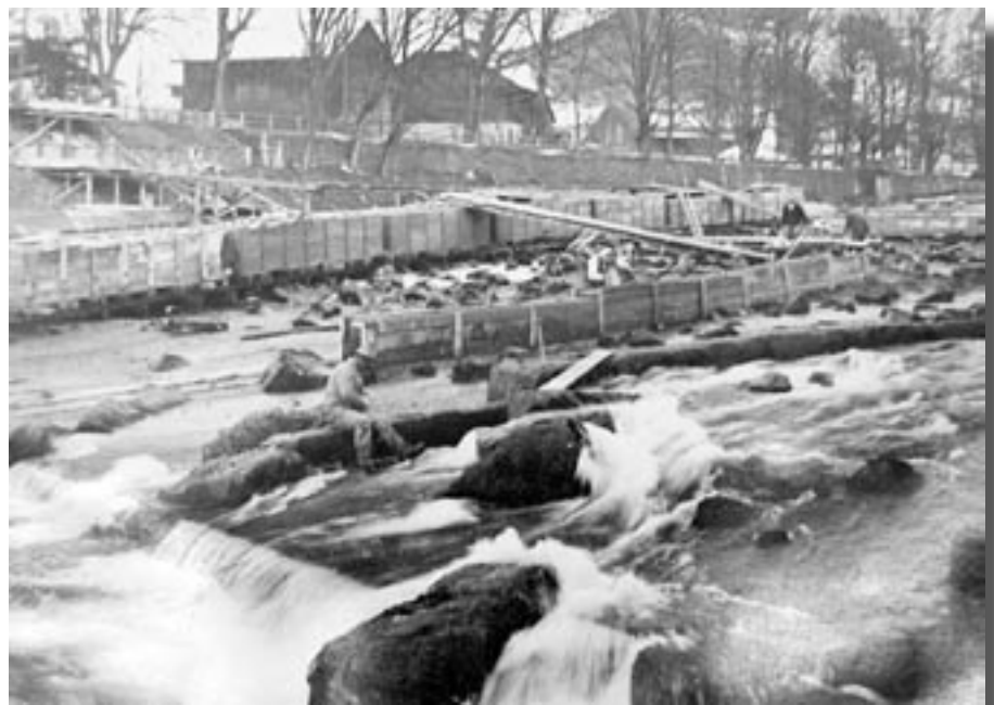
Bauarbeiten an der Aaresohle im Schwäbis, zwischen 1916 und 1926. Wegen der Rückwärtserosion der Aare nach der Aare-Zulg-Korrektur musste im Schwäbis die Flusssohle ab 1877 in mehreren Etappen mit Steinblöcken gesichert werden. Damals entstanden die Aarefälle. Zu Beginn der 1960er-Jahre verschwanden diese im Rückstau des Wehres, das damals für den Betrieb des neuen Elektrizitätswerkes errichtet wurde. (Foto aus: Bähler 2007)
